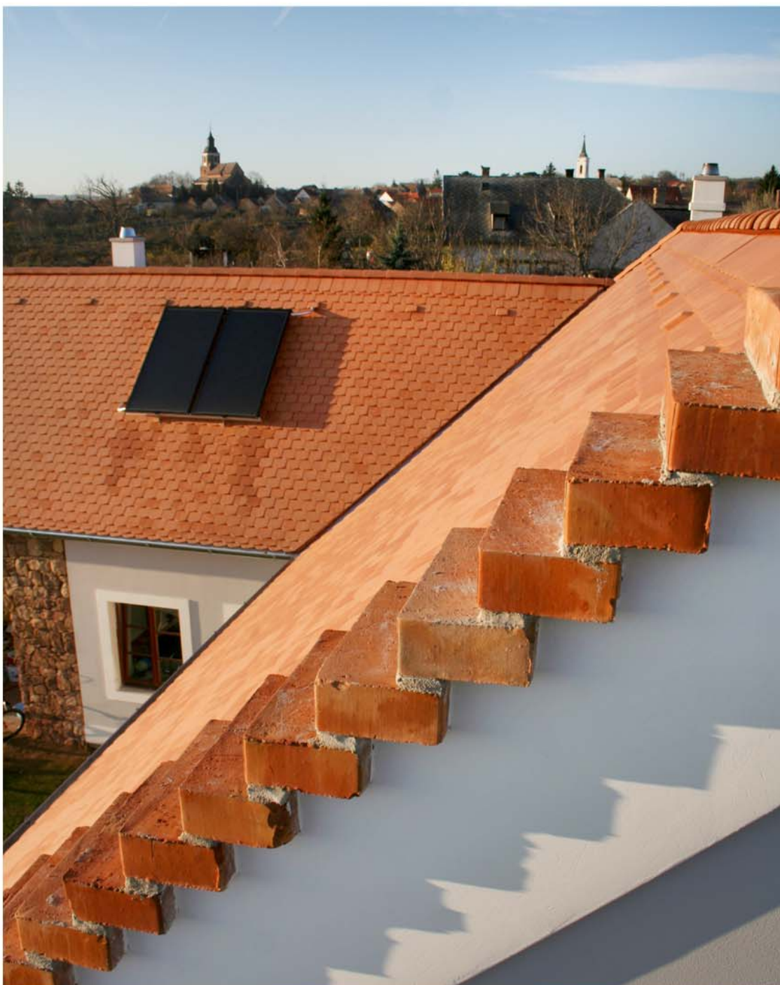
Hőhidmentesen kialakított macskalépcső
